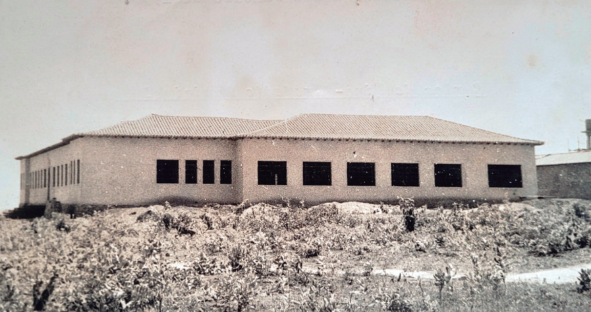
Primeiro pavilhão da Santa Casa construído ainda na década de 50
